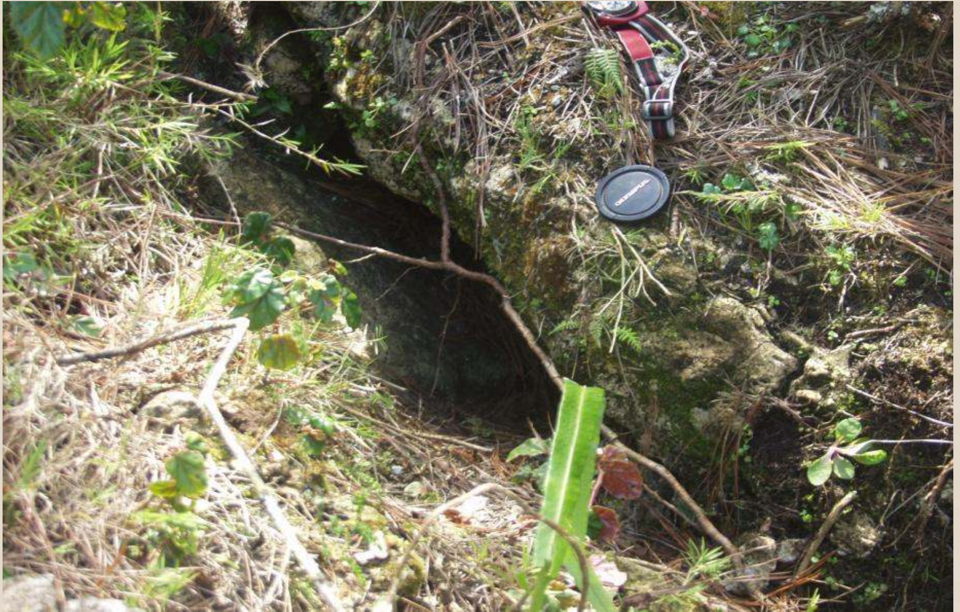
Hueco en el farallón de calizas conteniendo el nido 2
